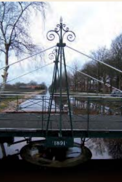
📍 In oude luister en kleuren herstellende draaibrug (met jaartal).
