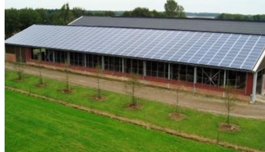
Figuur 5.1: Volledige dakbenutting voor zon-PV
